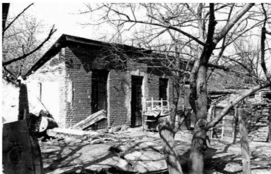
Хозяйственная постройка. 1990 г.
