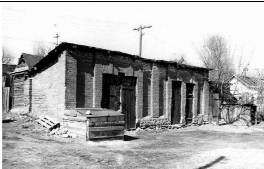
Хозяйственная постройка. 1990 г.
