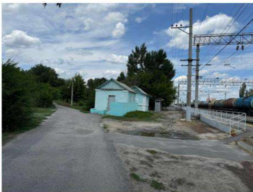
Фото 30. Вид на окружающую территорию. Дата съемки: 23 июня 2024 г.
