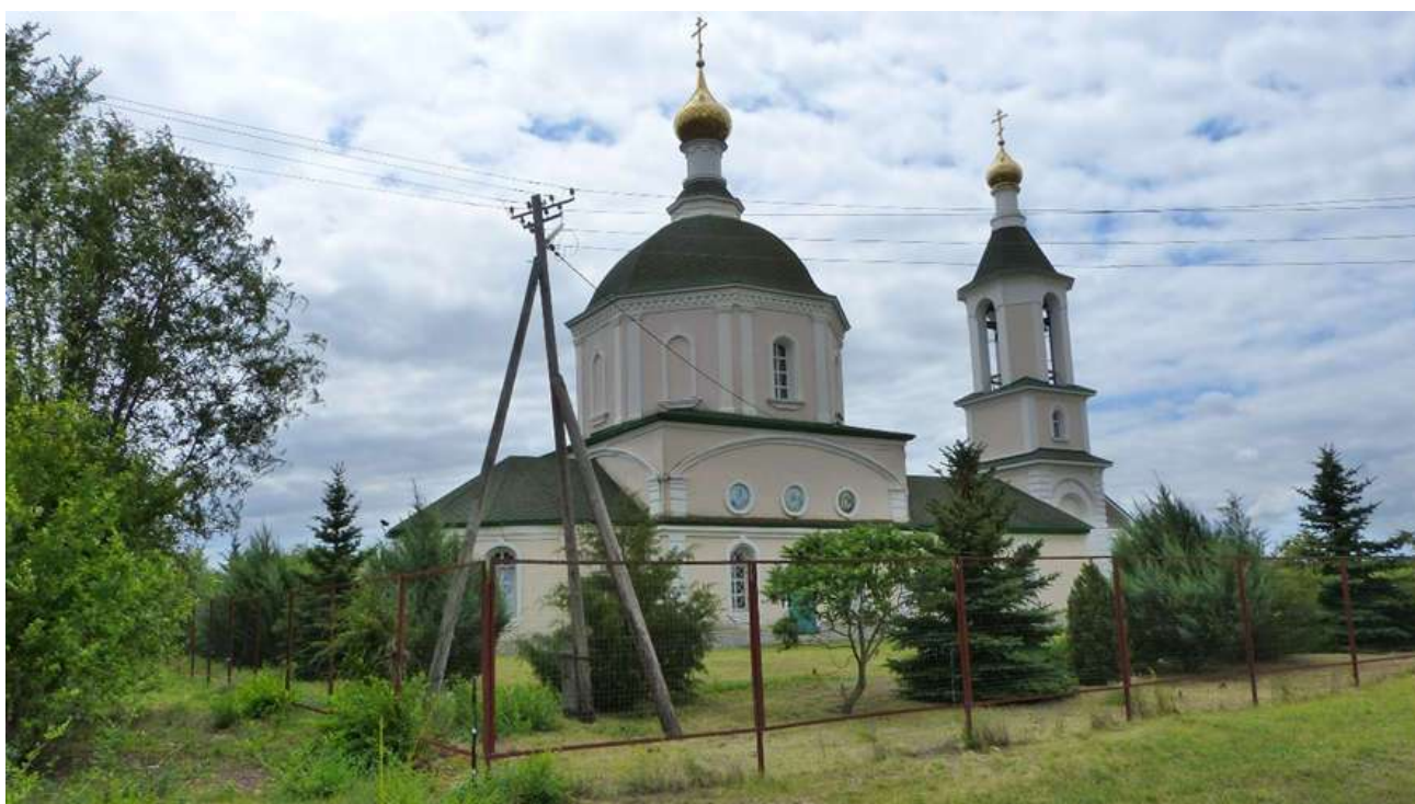
Вид Объекта в юго-западном направлении. Автор фотографии В.В. Котельников. 28.06.2024 г.
