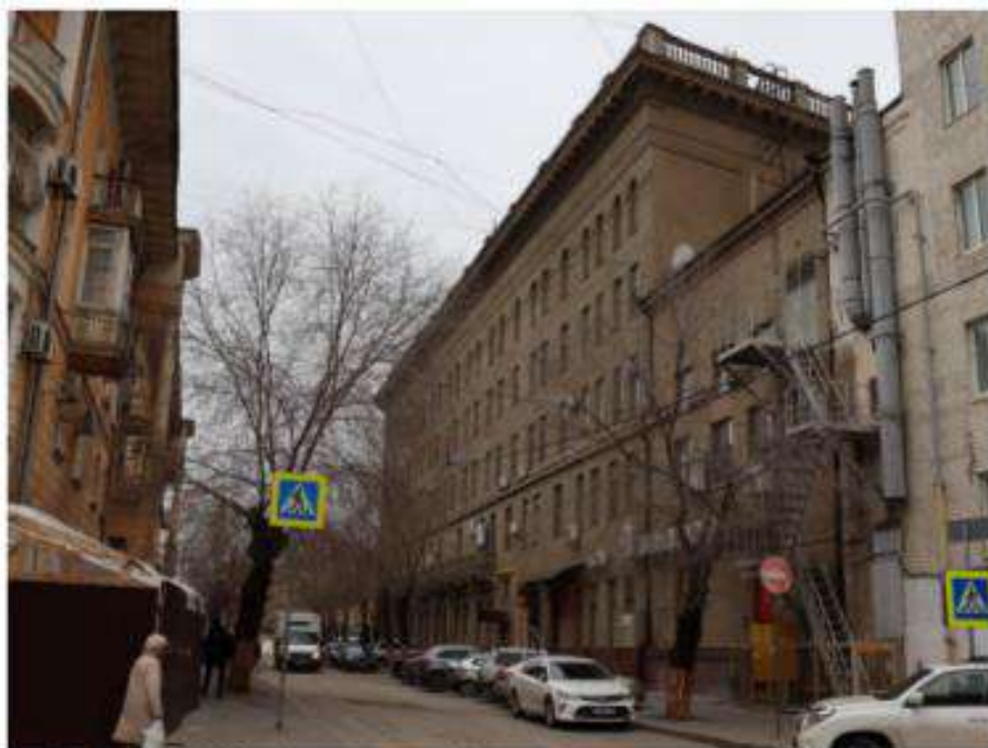
Фото 7. Вид на ОКН «Гостиница «Волгоград», элемент объекта культурного наследия «Комплекс застройки ул. Мира» со стороны ул. Володарского. Дата съемки: ноябрь 2023 г.
