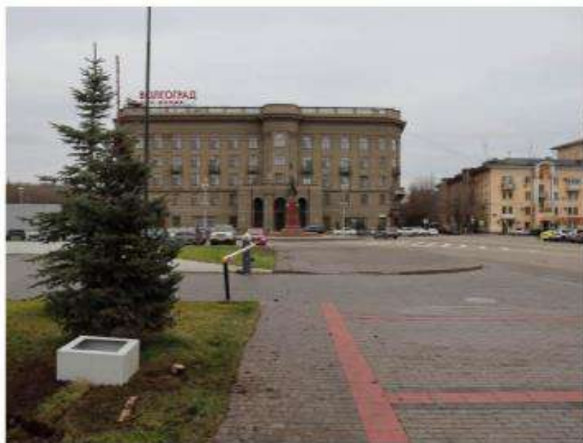
Фото 3. Вид на ОКН «Гостиница «Волгоград», элемент объекта культурного наследия «Комплекс застройки ул. Мира» со стороны площади Павших Борцов. Дата съемки: ноябрь 2023 г.
