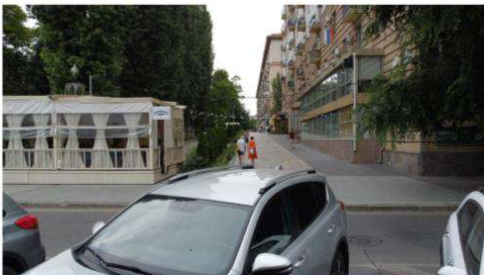
Фото 46. Вид на застройку ОКН «Комплекс застройки пл. Павших Борцов и Аллен Героев» с ул. им. Чуйкова. Дата съемки: июль 2024 г.
