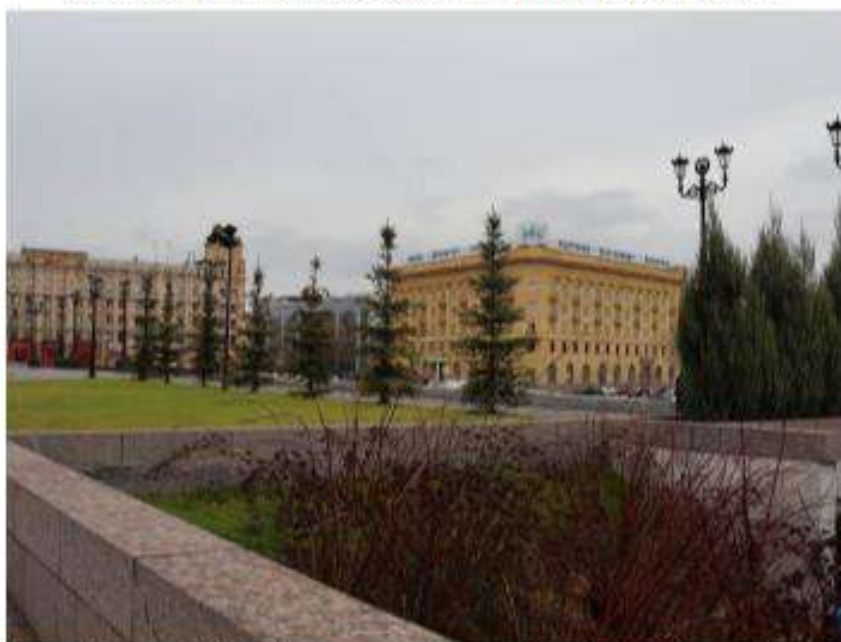
Фото 2. Вид на ОКН «Гостиница «Интурист», ОКН «Волгоградский главпочтамт» - элементы объекта культурного наследия «Комплексе застройки ул. Мира» со стороны площади Павших Борцов. Дата съемки: ноябрь 2023 г.
