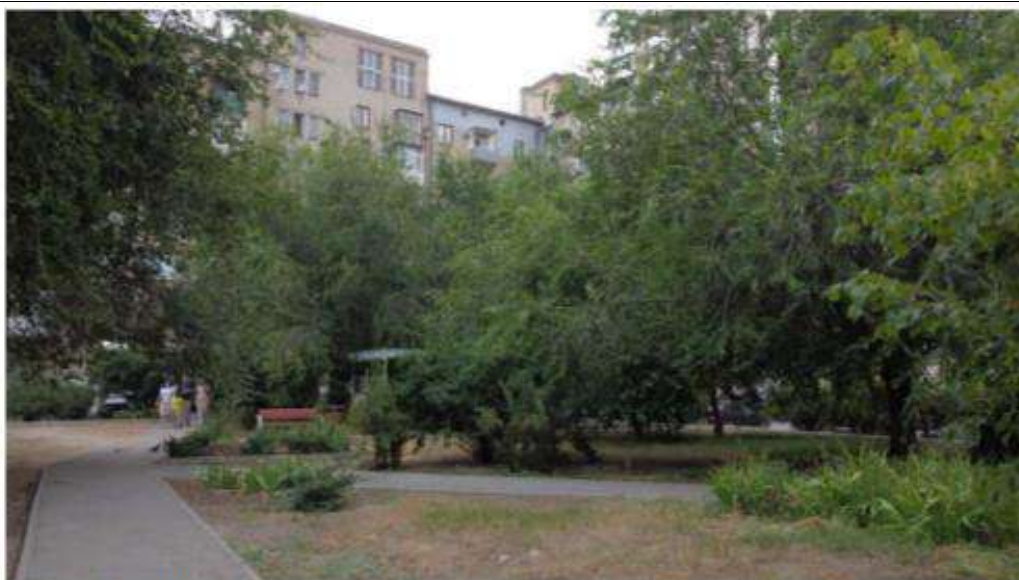
Фото 57. Вид на элементы ОКН «Комплекс застройки пл. Павших Борцов и Аллея Героев» - жилые дома по ул. Аллея Героев, 3 и ул. Аллея Героев, 5 со стороны внутреннего двора. Дата съемки: июль 2024 г.
