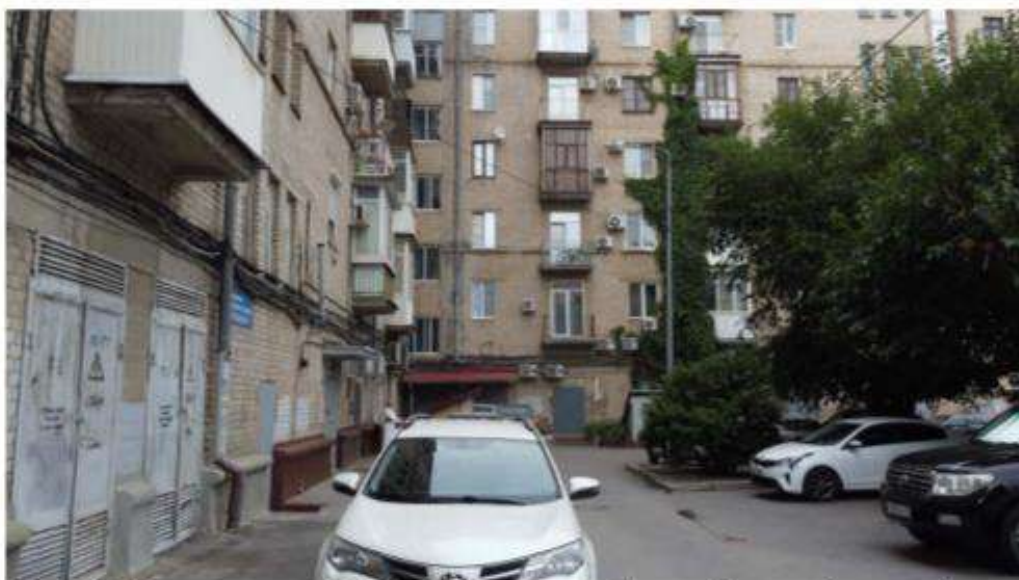
Фото 58. Вид на элемент ОКН «Комплекс застройки пл. Павших Борцов и Аллея Героев» - жилой дом по ул. Аллея Героев, 5 со стороны внутреннего двора. Дата съемки: июль 2024 г.
