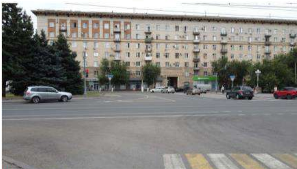
Фото 14. Вид на элемент объекта культурного наследия «Комплекс застройки пл. Павших Борцов и Аллеи Героев»: жилой дом по ул. Аллея Героев, 5. Дата съемки: июль 2024 г.
