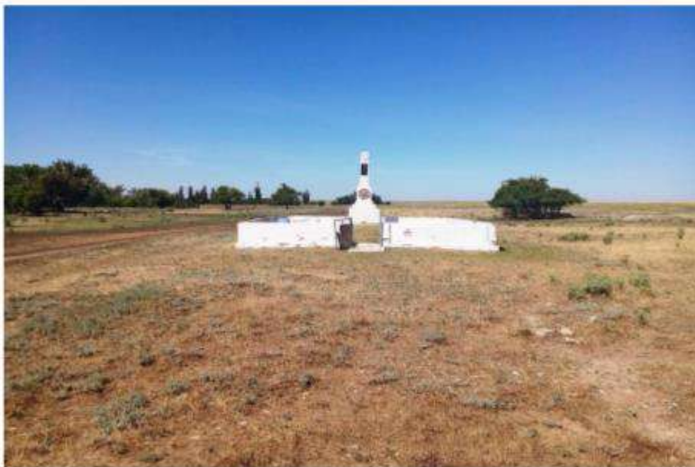
Съемочная точка №5 (10.07.2024 г. автор Макарычева Е.Г.) Вид с северо-восточной стороны.
