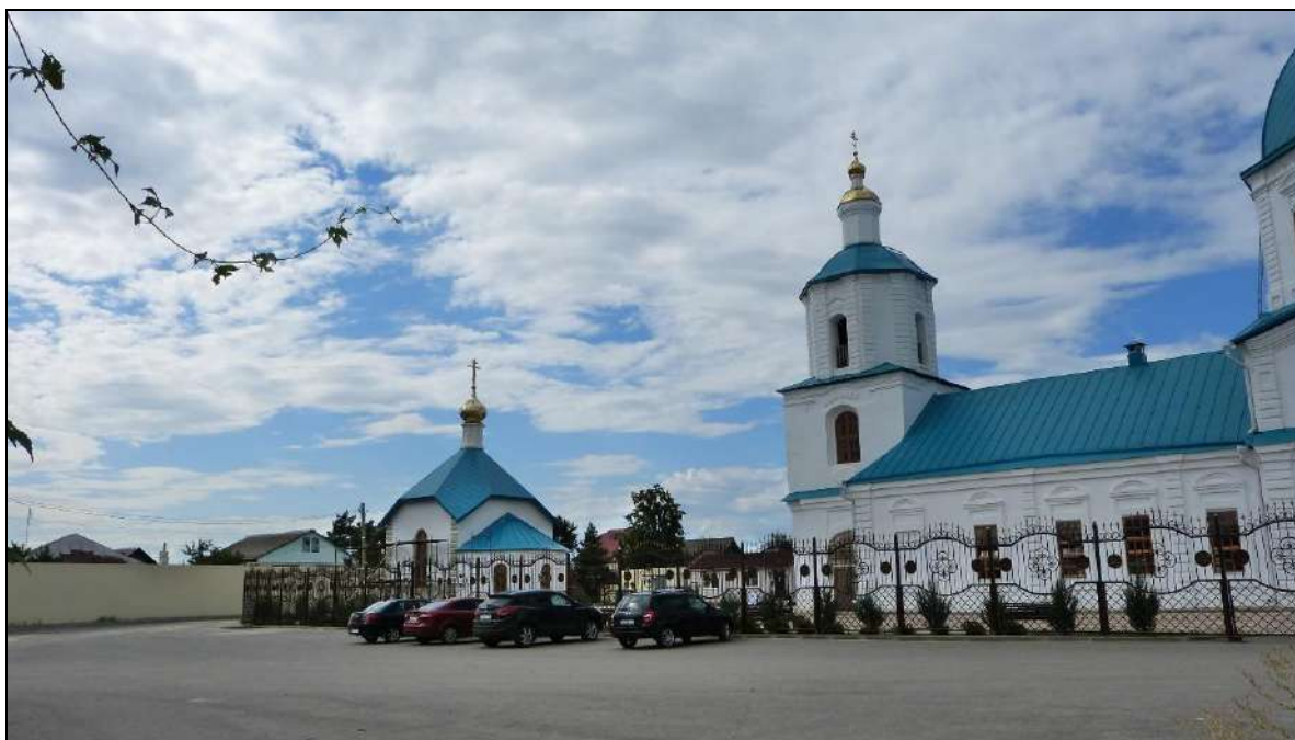
Вид Объекта (дальний план) в северо-западном направлении. Автор фото В.В. Котельников 28.07.2024 г.
