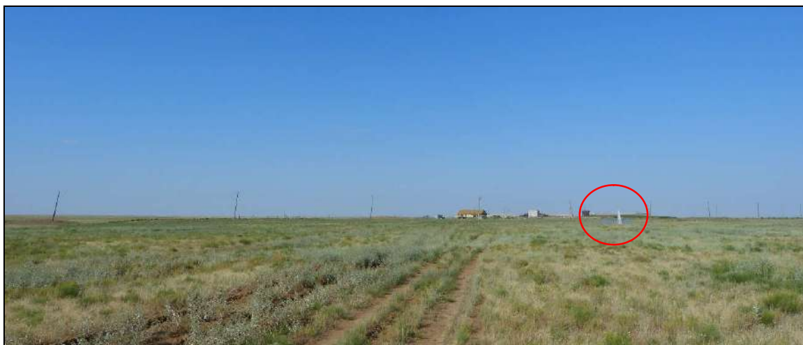
Дальний вид Объекта в восточном направлении. Автор фотографии Кулешов А.С. 28.07.2024 г.
